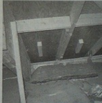
太陽光発電の穴を塞ぐための木(中央付近の短い木)が変更されていた不十分な工事の例
